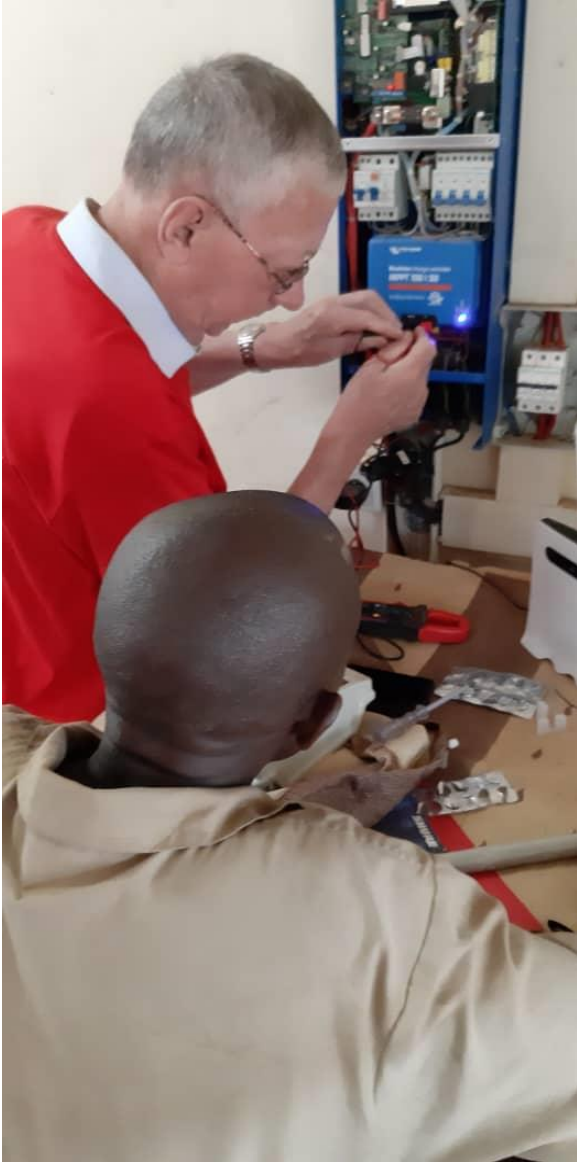
Onderhoud elektrische installatie via zonnepanelen
