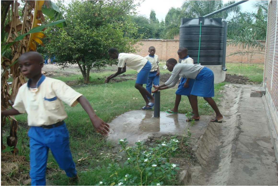
Enmaal geïnstalleerd profiteren de leerlingen van het water. installatie is gereed en formeel overgedragen het blindeninstituut Kanura
