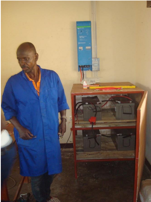
Installatie van de omvormer/lader en onderhoudsvrije accu's
