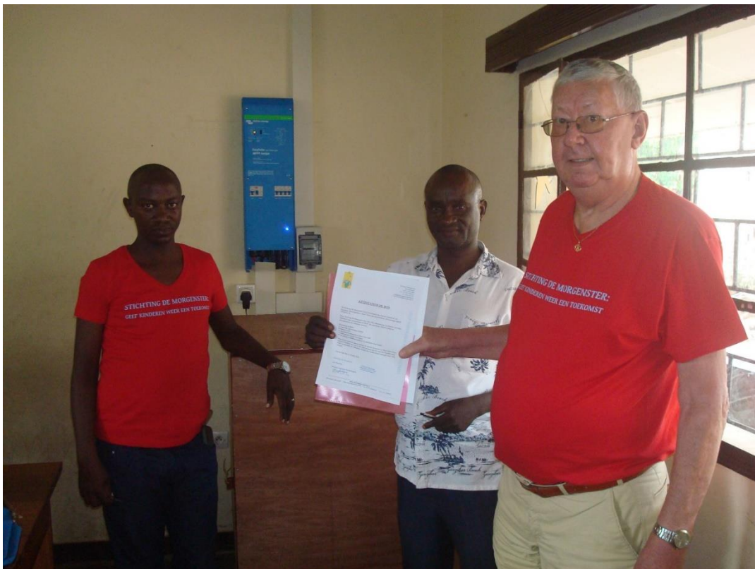
De installatie is afgerond en formeel overgedragen aan de EPPHATHA directie
