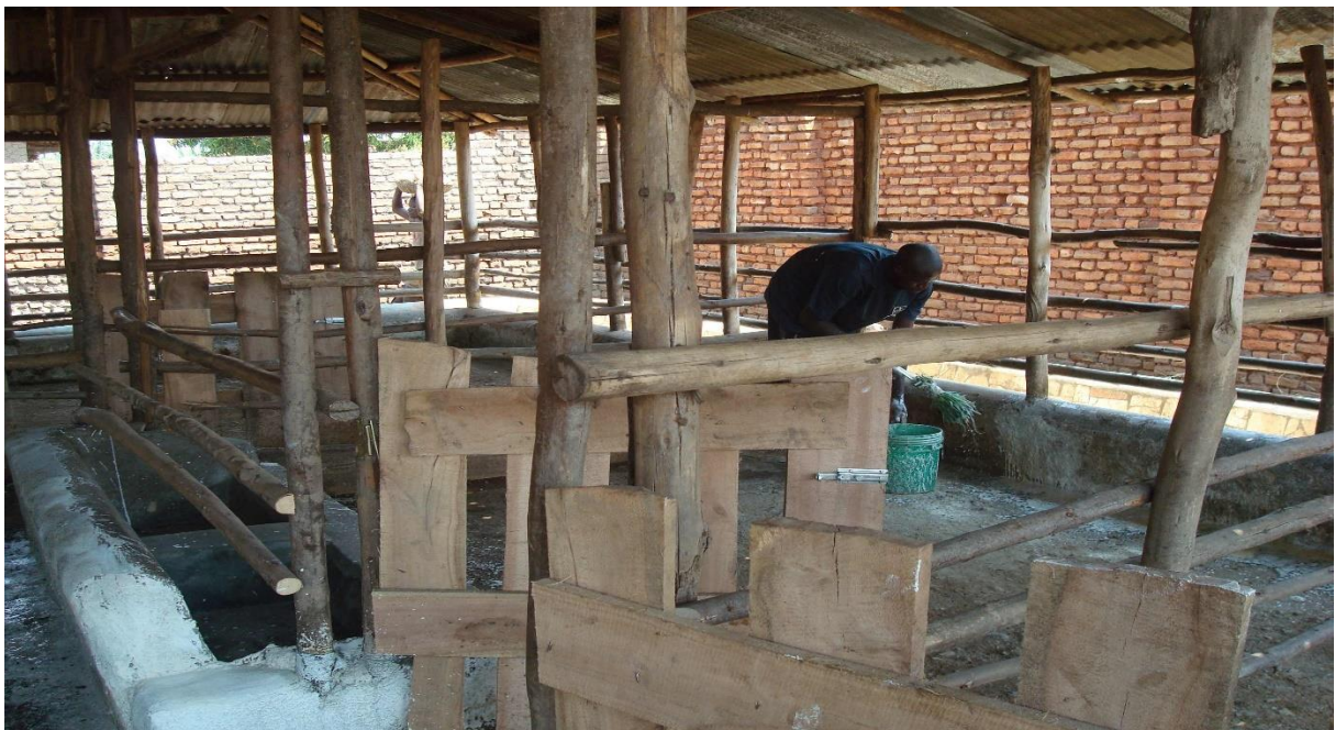
CEMENTEN VLOEREN MET WITKALK BEWERKT TEGEN INSECTEN); ELKE STAL HEEFT APARTE TROGGEN VOOR VOEDSEL EN WATER
