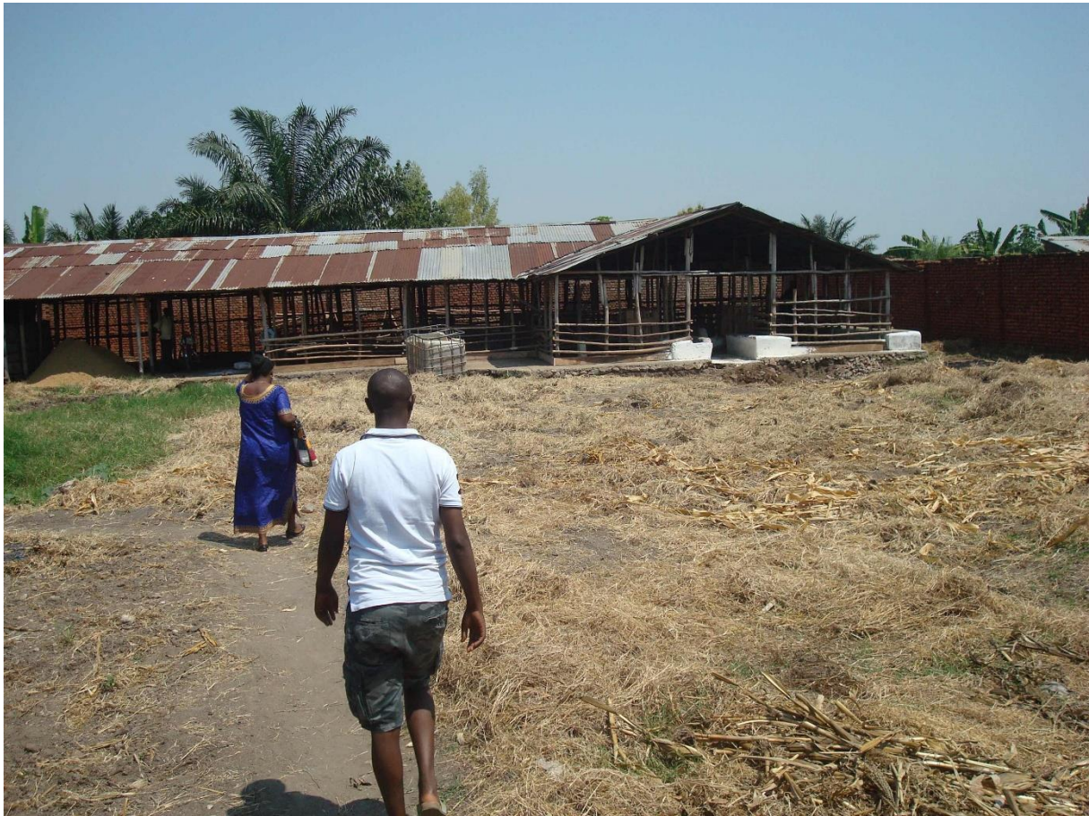
BOUW VAN DE STALLEN VOOR IN EERSTE INSTANTIE 10 ZEUGEN EN ÉÉN BEER
